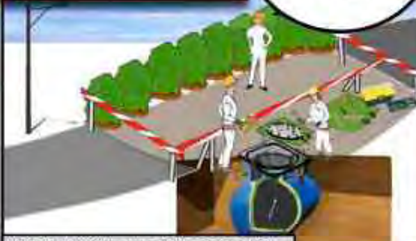
VERIFICA CON MULTIGAS E Sonda
